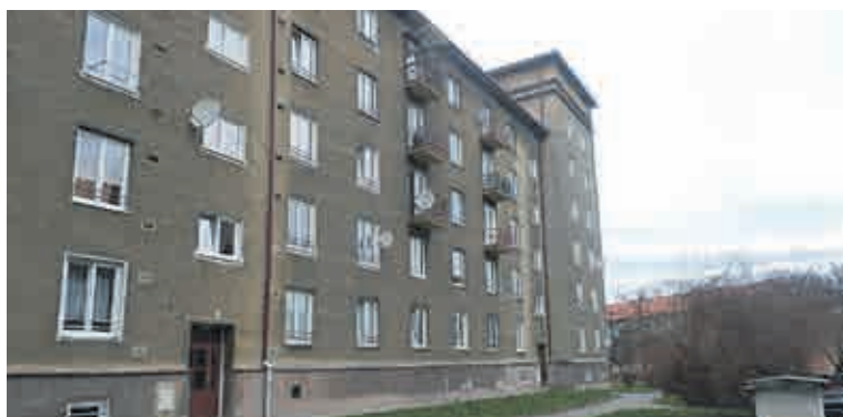
Blok 85 před rekonstrukcí...
