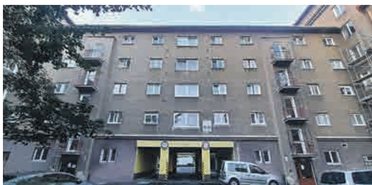
Blok 85-86 před rekonstrukcí...
