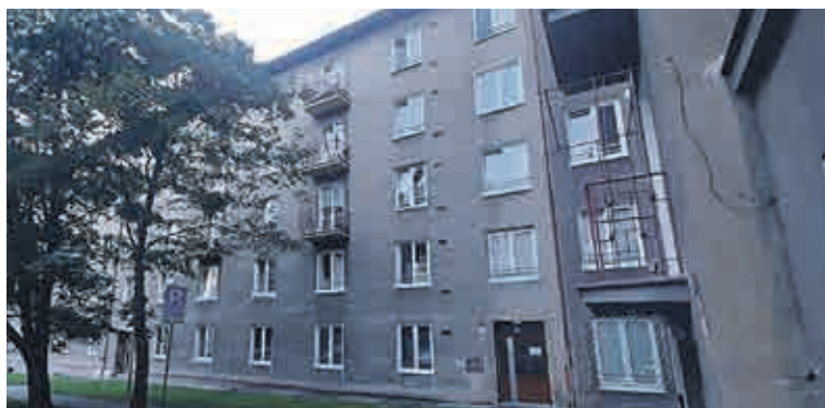
Blok 86 před rekonstrukcí...
