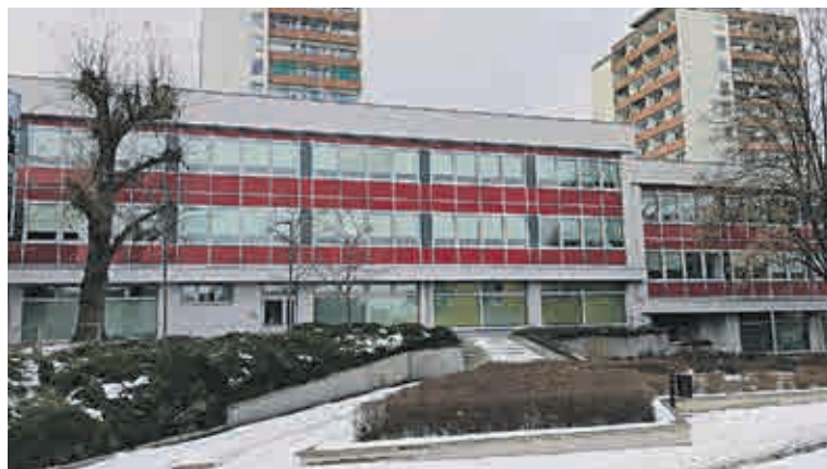
Tady bude nově sídlit OSSZ Most. V objektu byly kdysi obchody, kanceláře a také hospoda. V polovině budovy sídlí od devadesáté úřad práce. Zbývá část byla po opuštění dlouho zavřená a chátrala, než ji stát zmodernizoval pro OSSZ.
