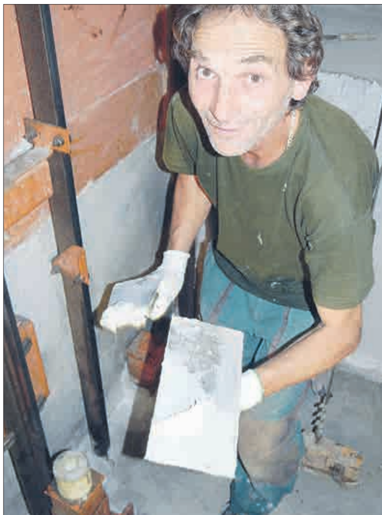
„Pracujeme na poslední vrstvě hydroizolace,“ vysvětlil Jiří Vávra.
