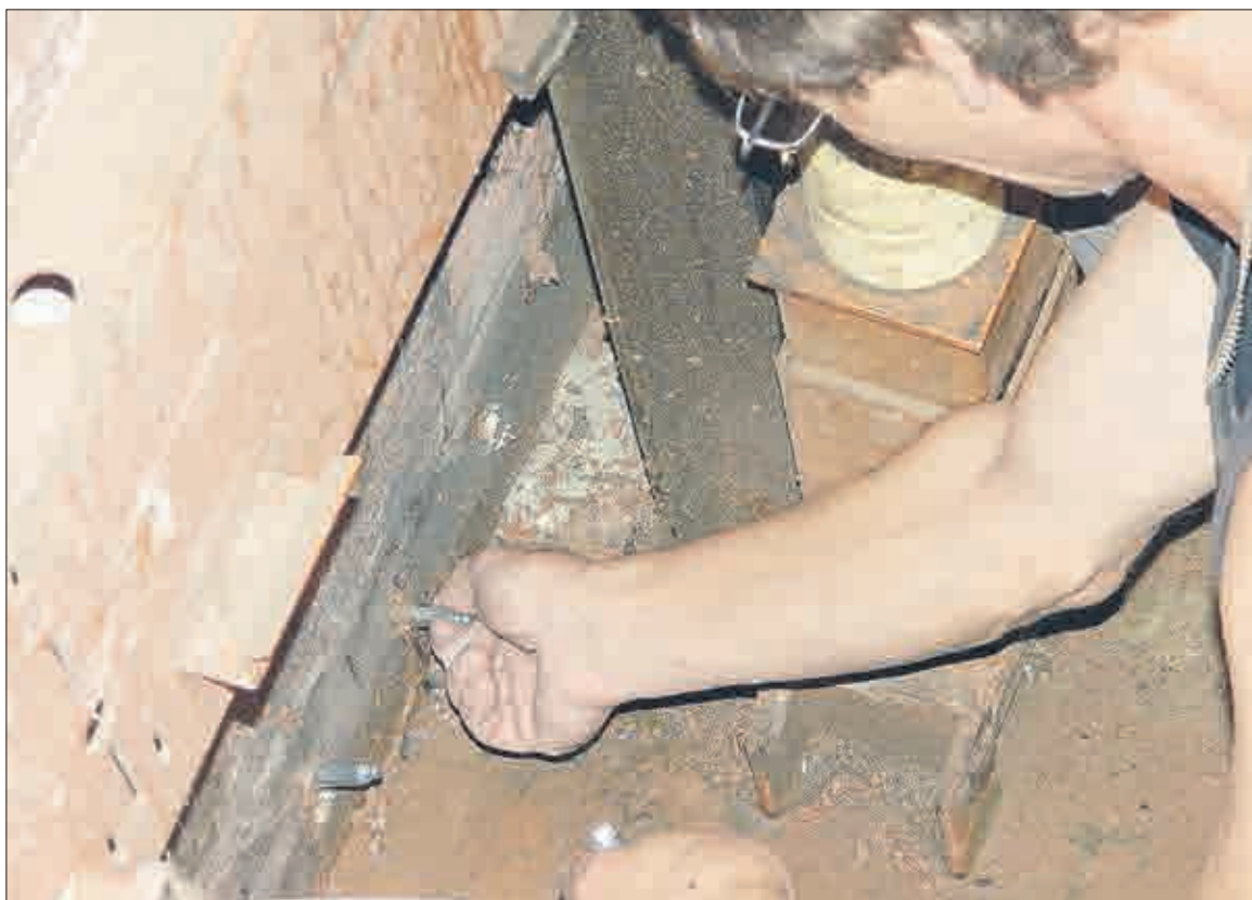
Injektážní hmoždinky byly vpraveny do stěn šachty.
