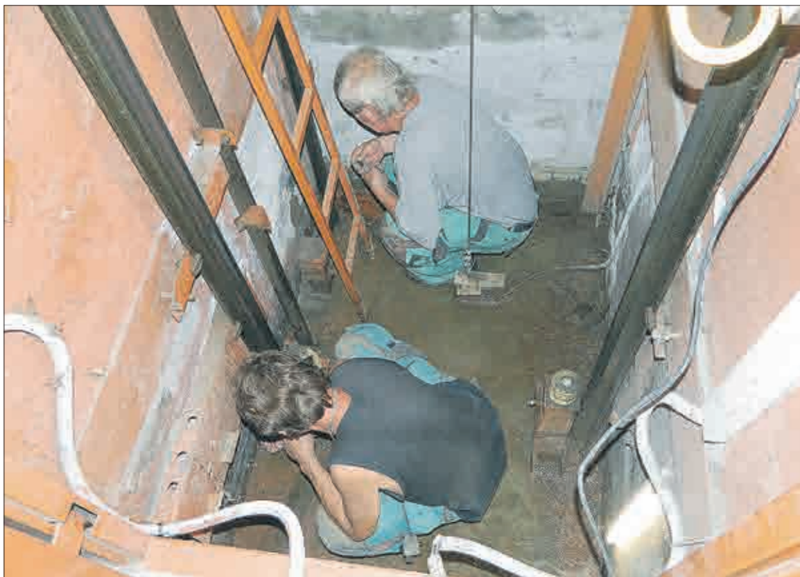
Práce na dně výtahové šachty není nic příjemného.
