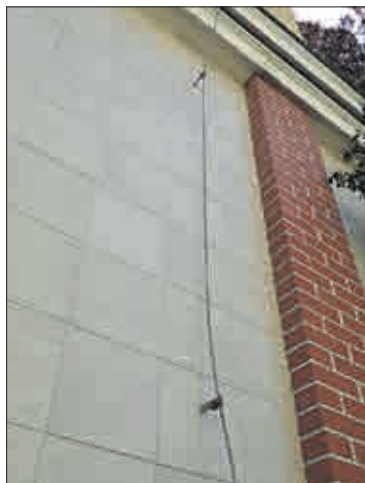
Vizuálně musí být hromosvod zkontrolován po celé své délce každoročně a revizní zpráva se zabývá i popisem úchytlů.
